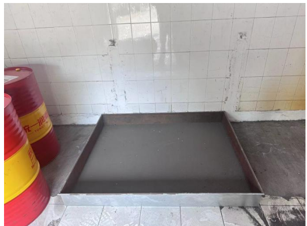
危废仓库防腐防渗
