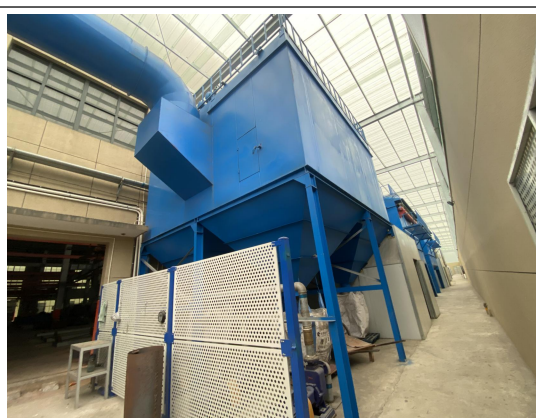
熔化废气收集、耐高温袋式除尘器
