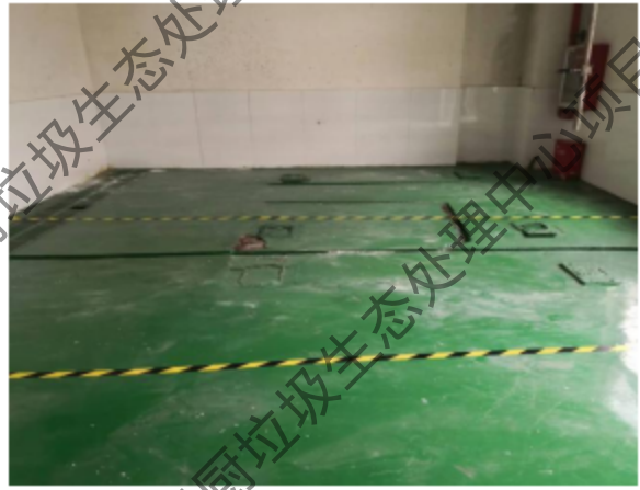
危废仓库-内部分区
