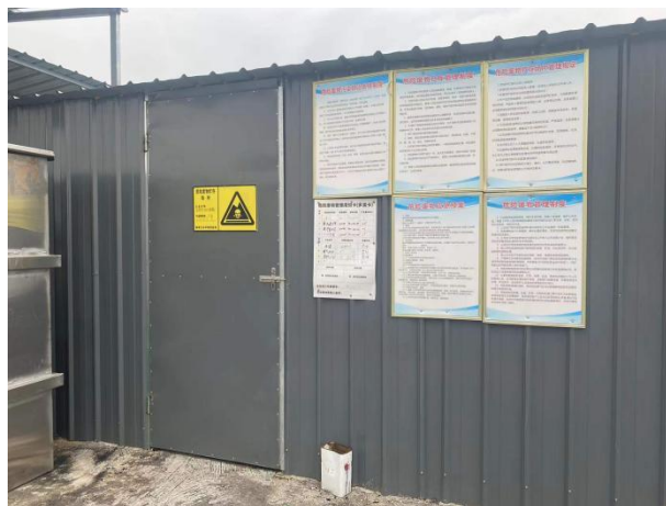
危废仓库外部
