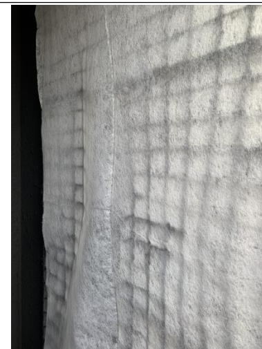
油漆废气处理设施--过滤棉
