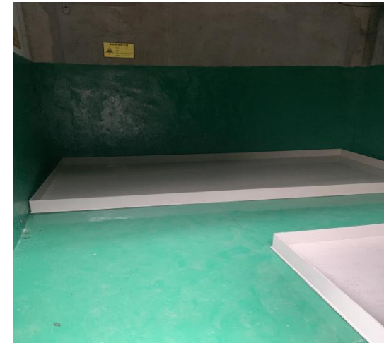
危废储存间（内）
