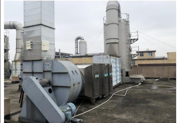
喷漆废气处理设施（水喷淋+过滤棉+光催化氧化+活性炭吸附）
