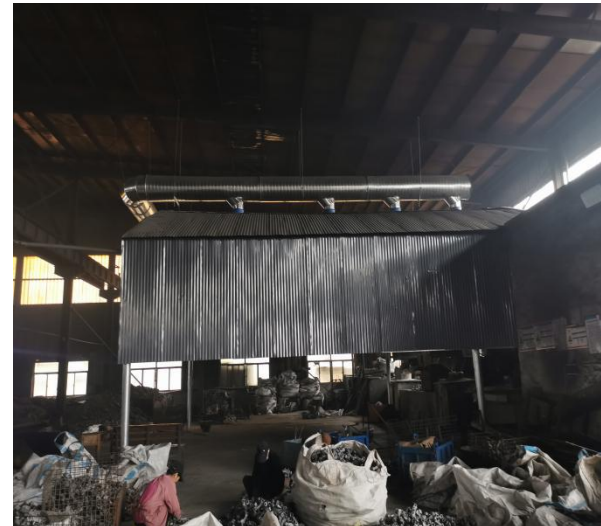
浇筑废气收集装置
