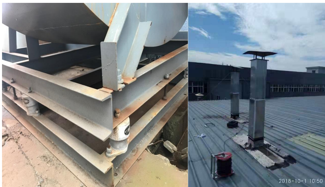
图 3-10 减震片（左）和排气筒（右）
