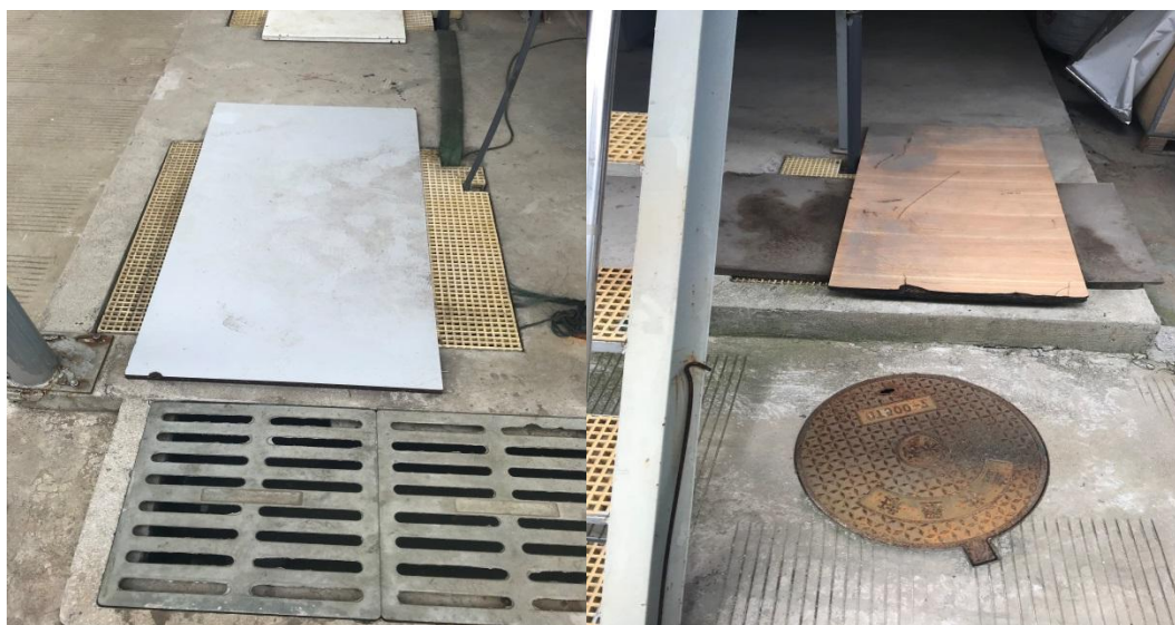
图 3-2 生产废水汇集池采样点（左）和生产废水排放口采样点（右）
