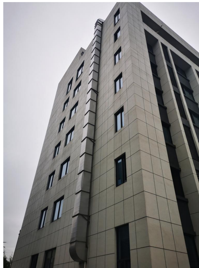
食堂油烟废气屋顶排放
