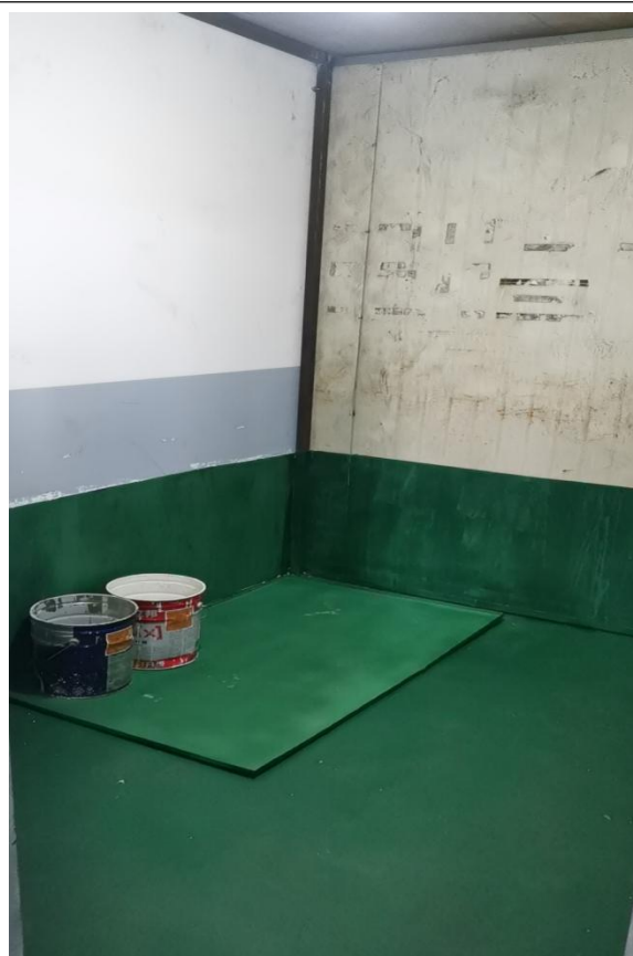
危废仓库内部
