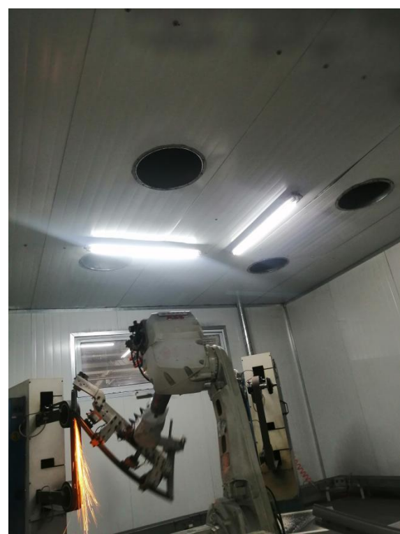
密闭间机器人打磨作业
