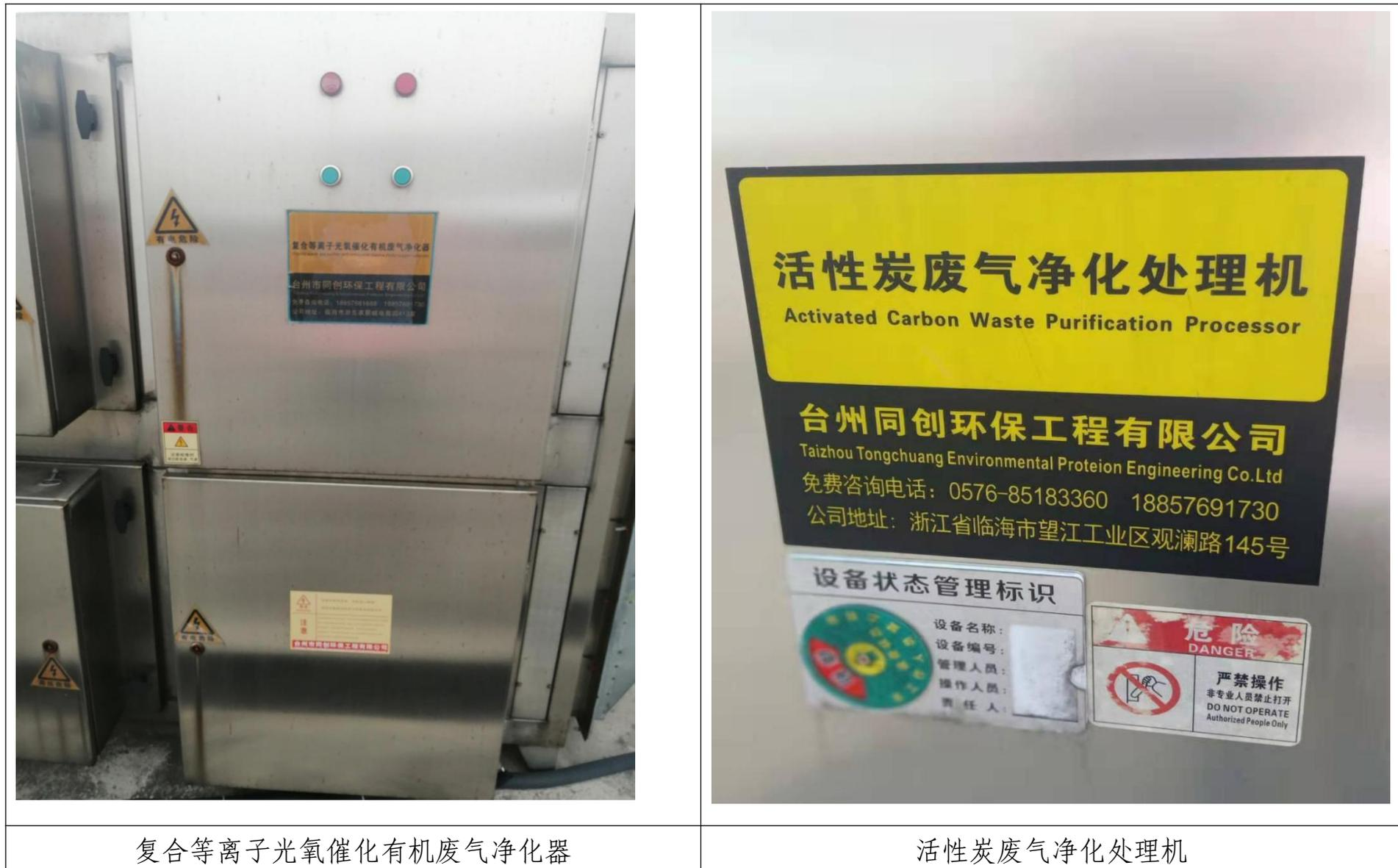
复合等离子光氧催化有机废气净化器
