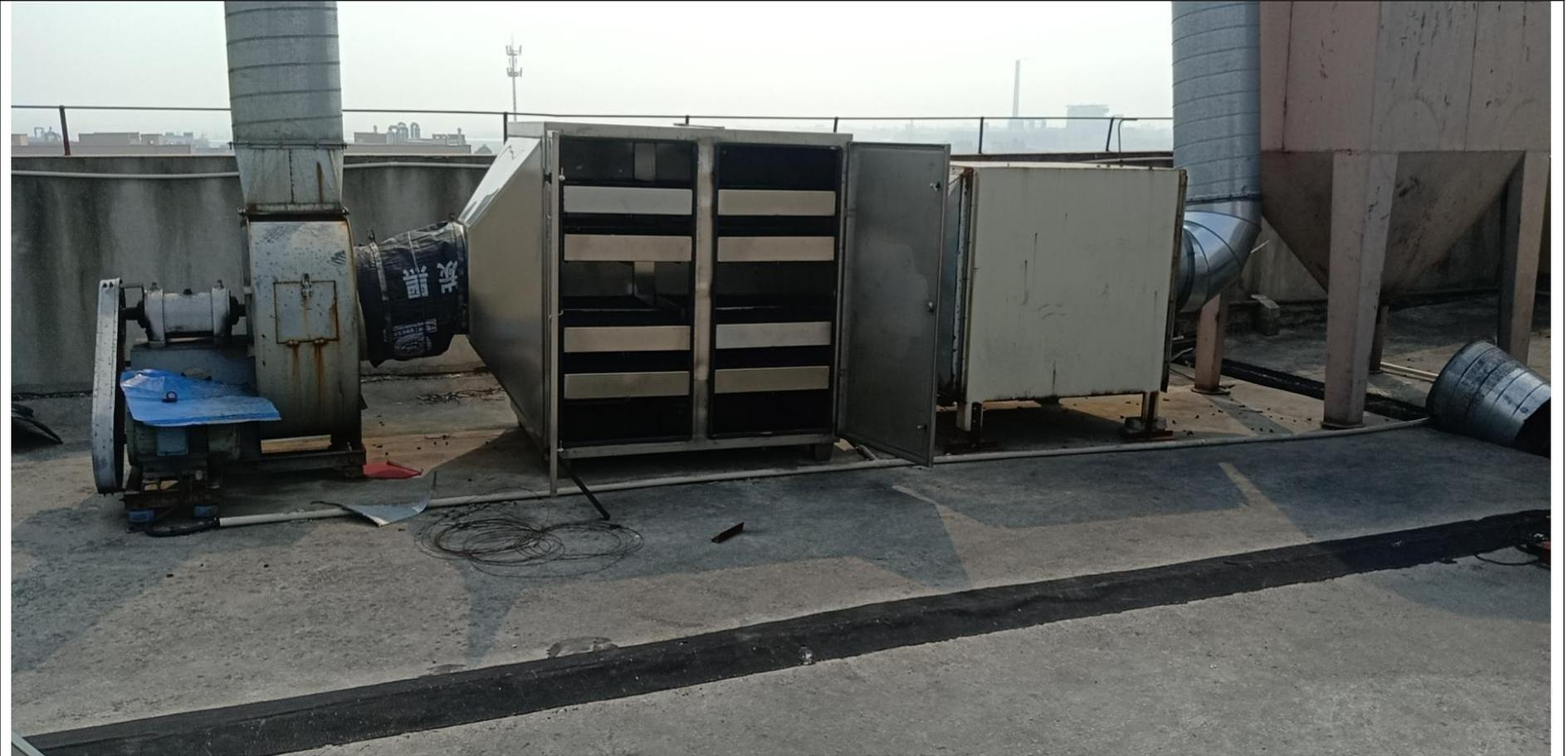
炼胶废气处理设施：布袋除尘+UV光气催化+活性炭吸附+27m高排气筒高空排放
