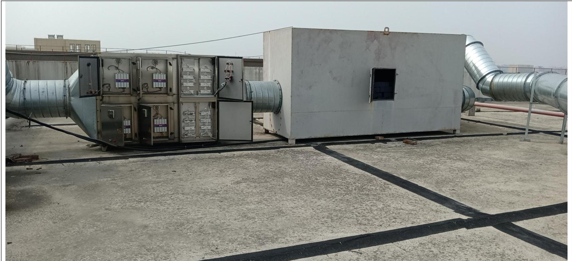
硫化废气处理设施: 复合等离子光氧催化有机废气净化器+活性炭吸附+27m排气筒高空排放
