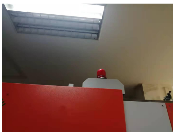
图 4-2 防护门上的电离辐射警示标志及警示灯
