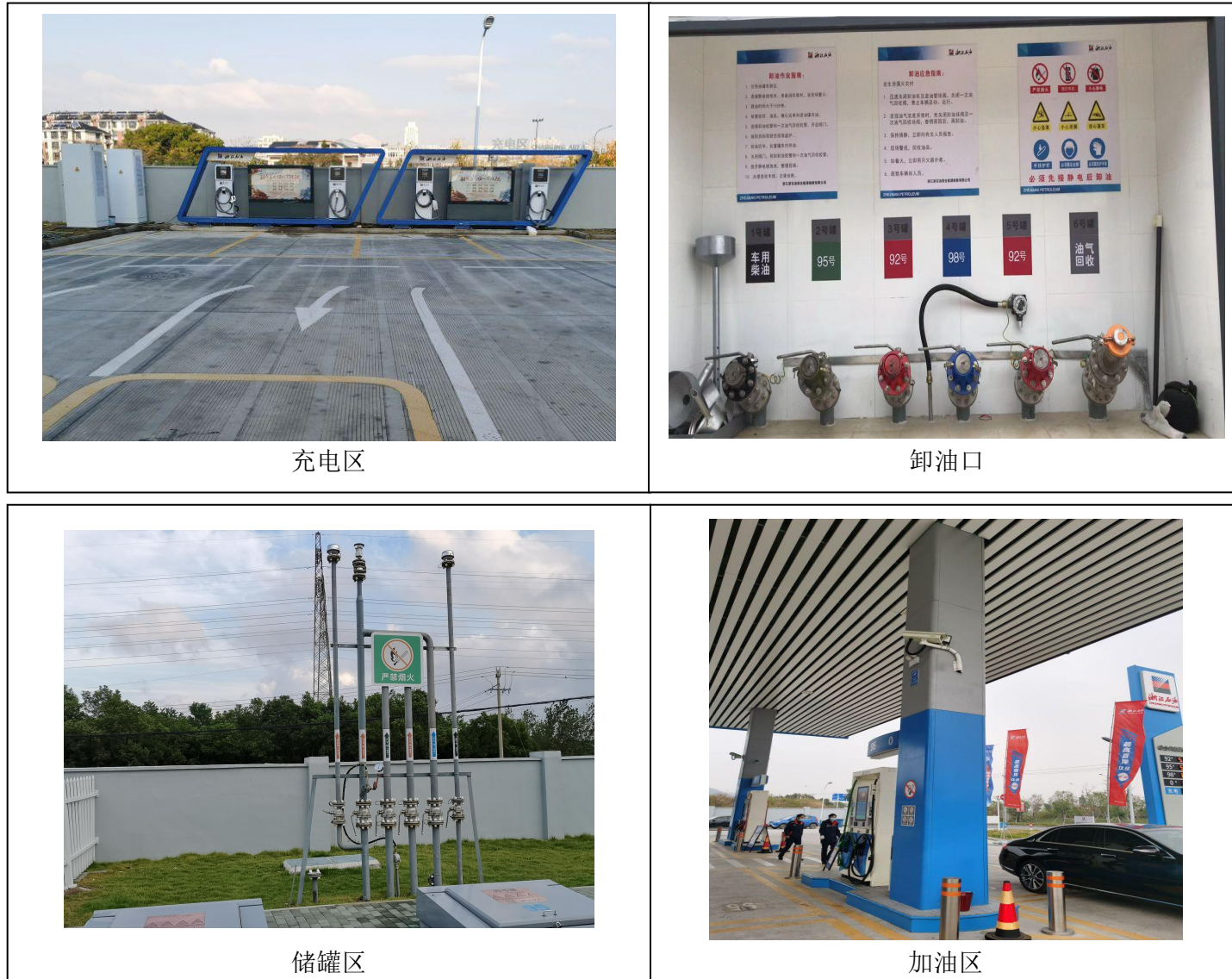
附图 4：厂区实际情况照片
