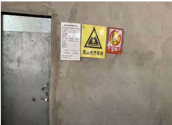
危废仓库（外部）
