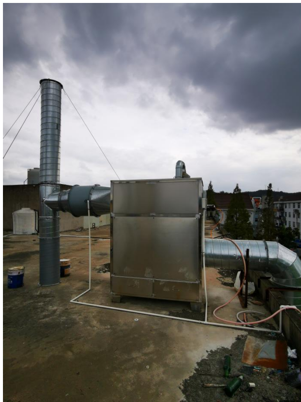
磨水口、拉砂、割片废气处理设施
