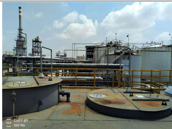
污水处理站加盖
