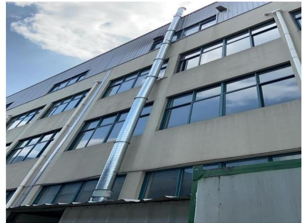
注塑废气排气筒 (离地 15m)
