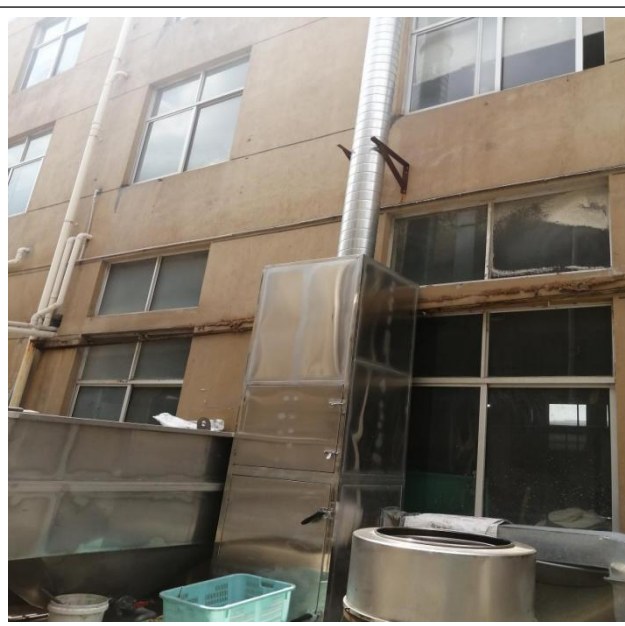
拉砂、磨水口、割片废气：布袋除尘
