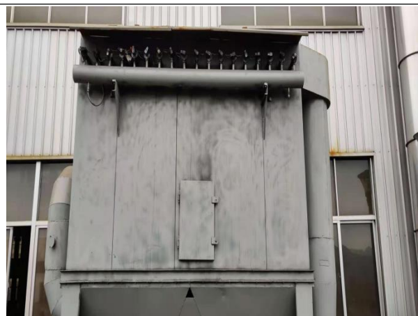
打磨粉尘废气处理设施
