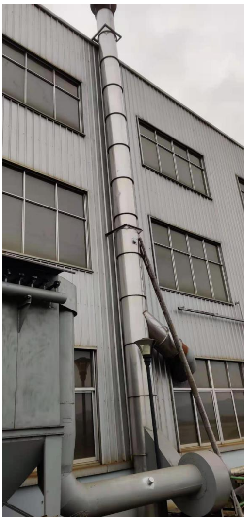
打磨粉尘废气排气筒
