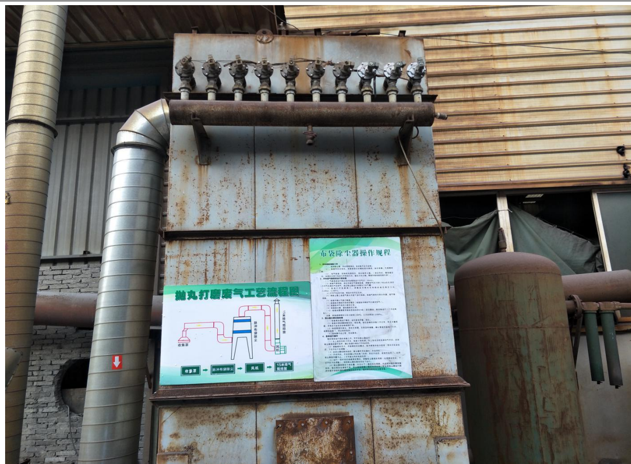
抛丸打磨废气处理设施（集气罩+脉冲布袋除尘装置+15m 排气筒）
