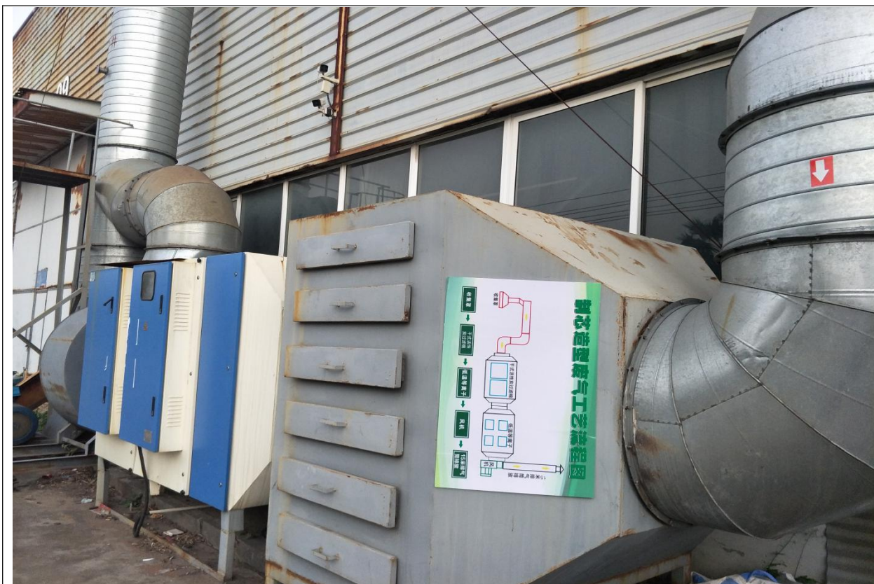
制芯及造型废气处理设施（集气罩+干式活性炭过滤棉+低温等离子装置+15m 排气筒）
